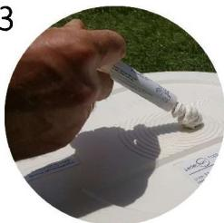
Cortar la boquilla del aplicador desde su base y aplicar todo el contenido de adhesivo flexible de polímero en el centro de la parte trasera, sin extenderlo. Solo es necesario el contenido de un aplicador.
